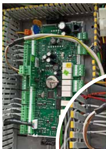
⑦b Particolare connessione \mu PC BMS
