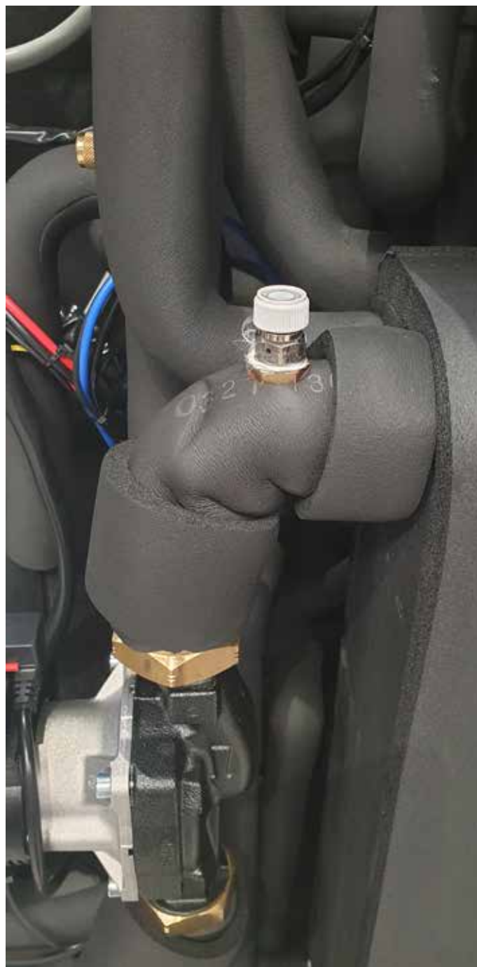
Entlüftungsventil, Monoblock Version.
